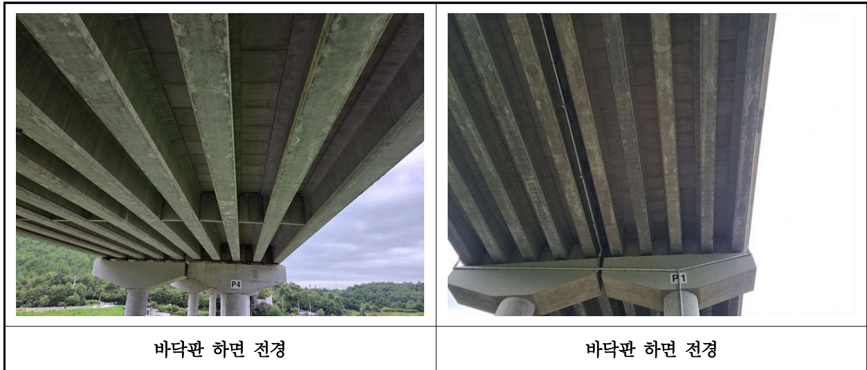
【사진 20.3.2】 바닥판하면 전경
