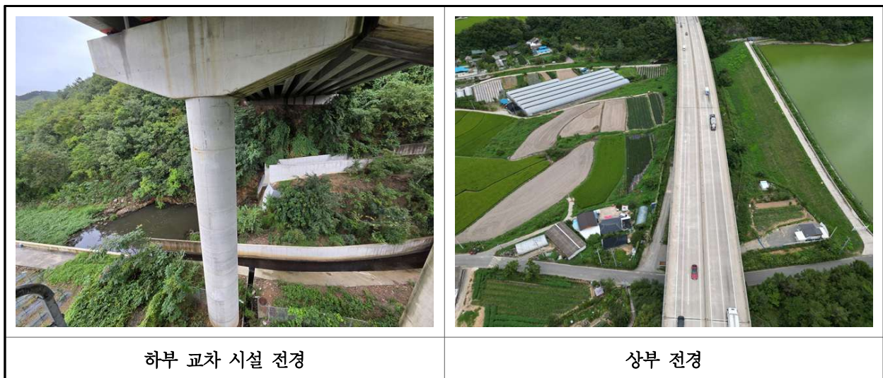
【사진 20.2.1】 부재 현장측정 전경
