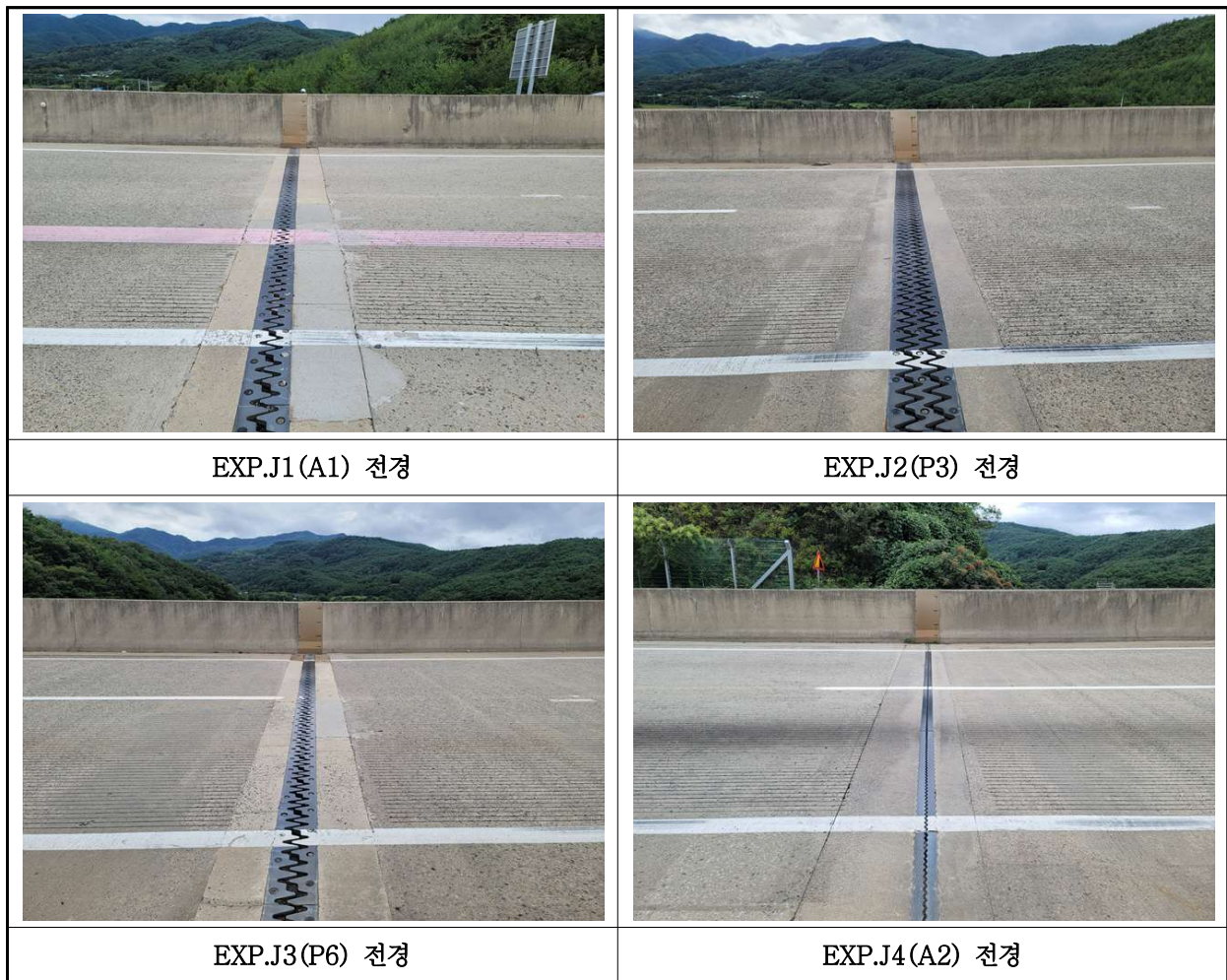
【사진 20.3.17】 신축이음장치 전경
