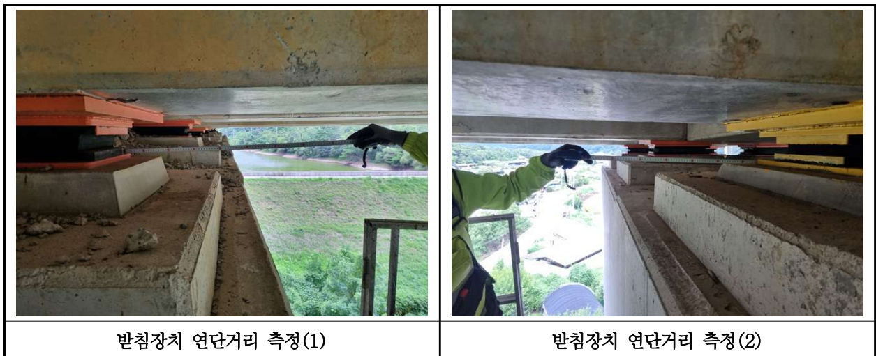
【사진 20.3.15】 교량받침장치 연단거리측정
