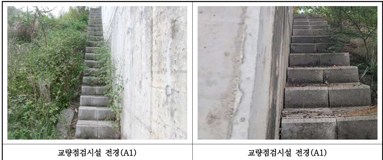
【사진 20.3.53】 교량 점검시설 전경
