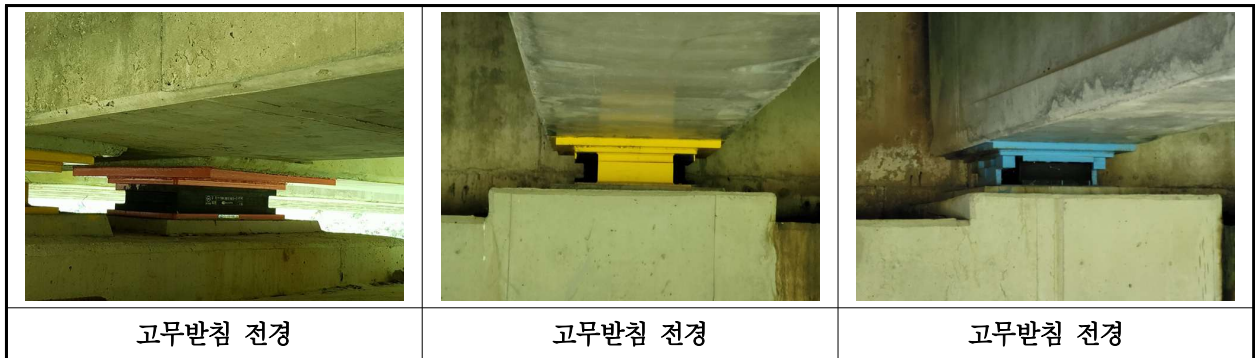
【사진 20.3.40】 교량반침 전경
