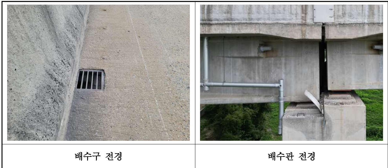
【사진 20.3.22】 배수시설 전경
