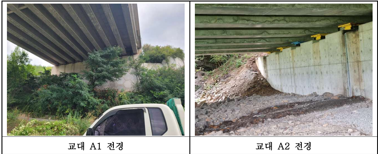
【사진 20.3.8】 교대 전경
