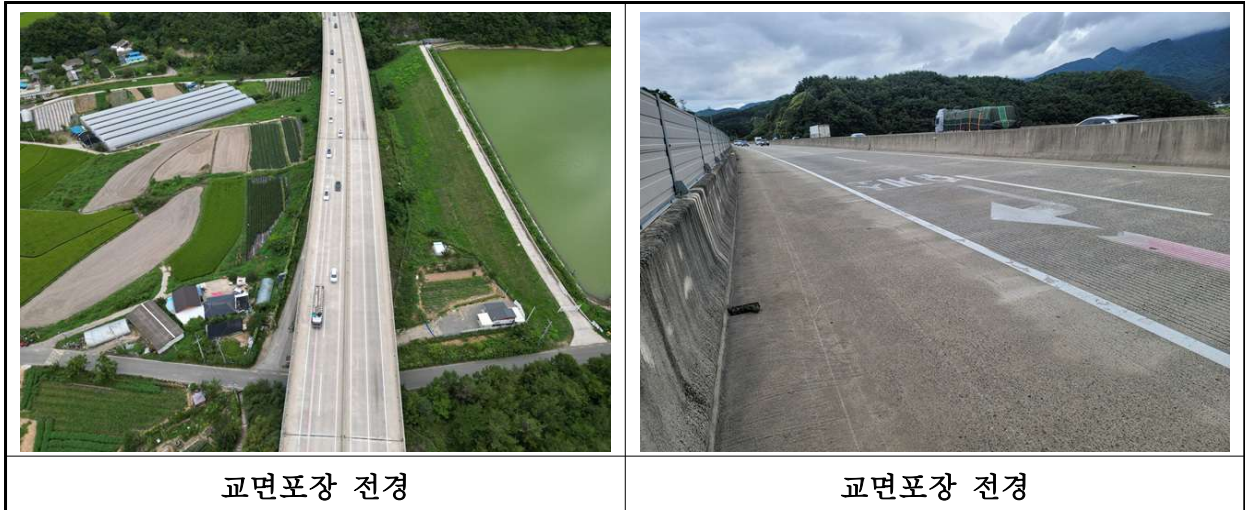
【사진 20.3.20】 교면포장 전경
