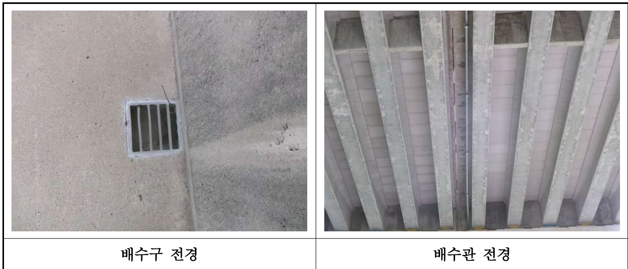
【사진 20.3.49】 배수시설 전경
