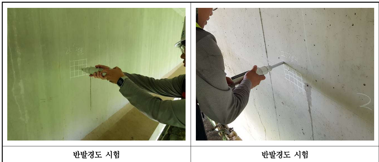
【사진 20.4.2】 반발경도시험 현장사진
