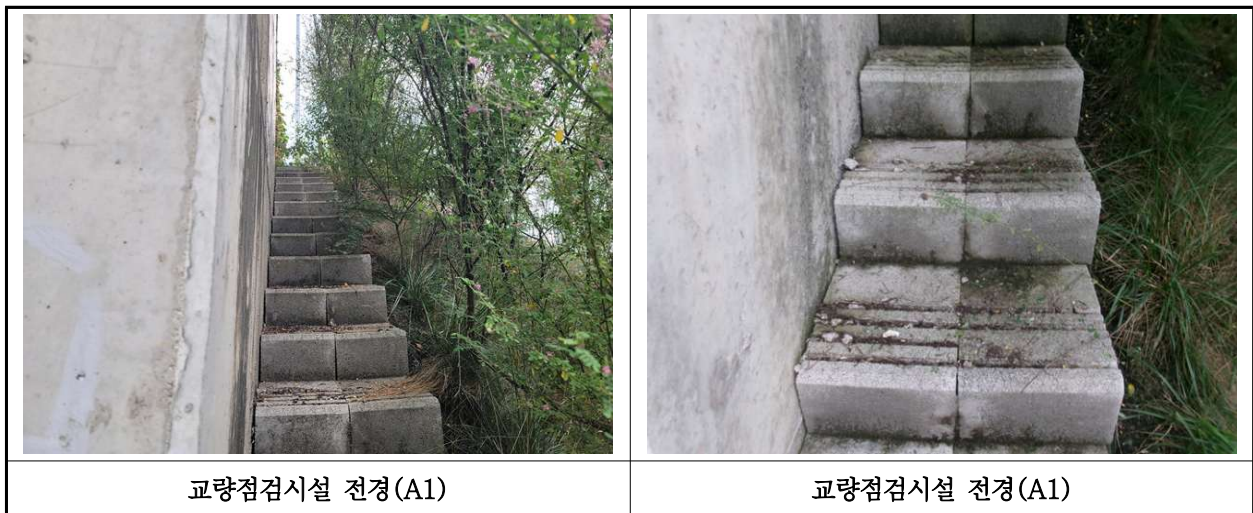
【사진 20.3.26】 교량 점검시설 전경
