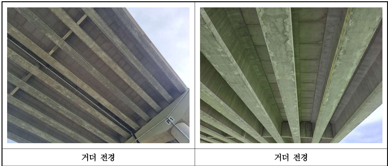
【사진 20.3.4】 거더 전경
