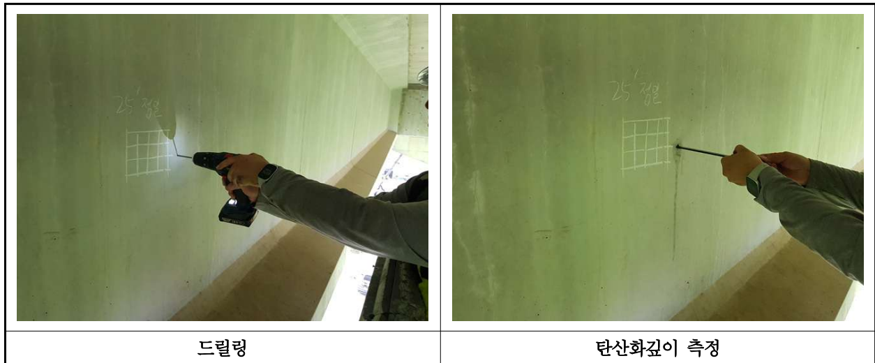
【사진 20.4.3】 탄산화 깊이 측정 현장사진
