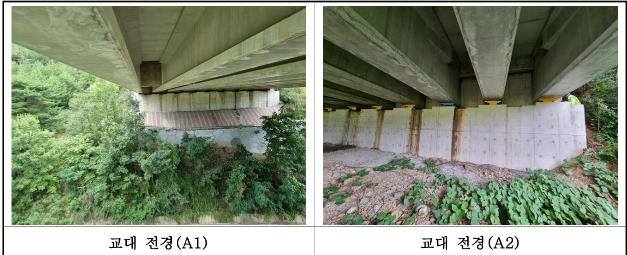
【사진 20.3.35】 교대 전경
