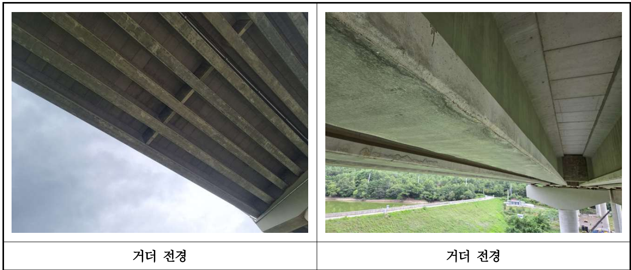
【사진 20.3.31】 거더 전경
