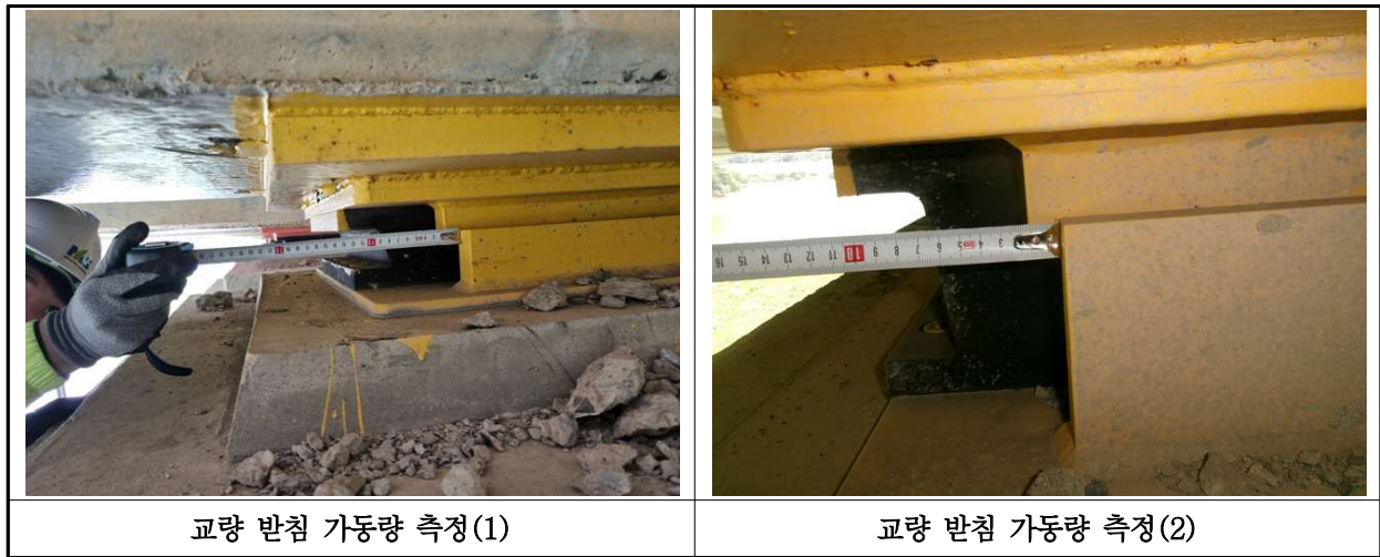
【사진 20.3.43】 교량받침 이동량 측정
