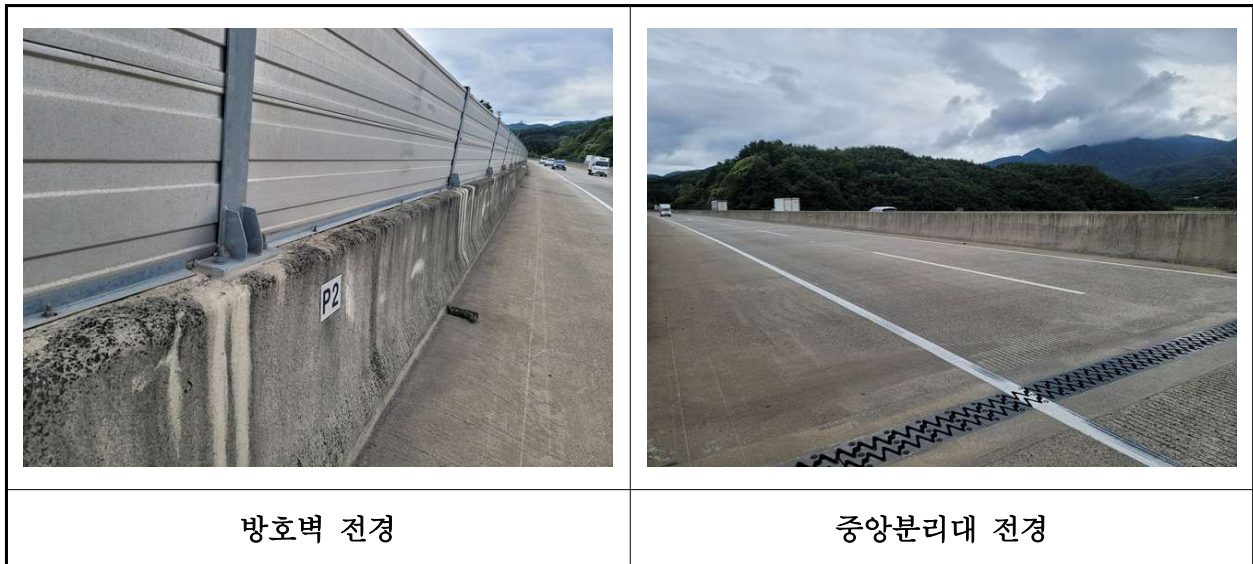
【사진 20.3.24】 방호벽 및 중앙분리대 전경
