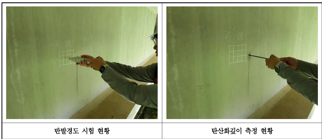
【사진 20.4.1】 콘크리트 내구성조사 현황
