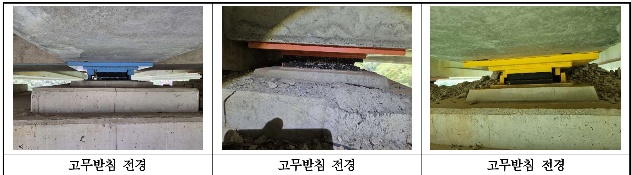
【사진 20.3.13】 교량반침 전경
