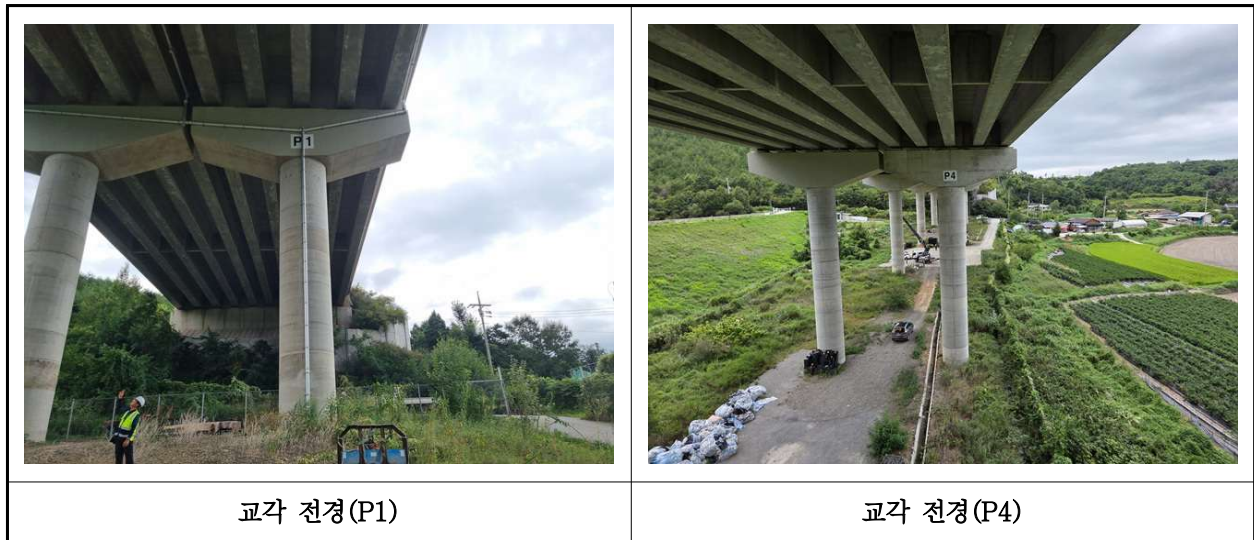
【사진 20.3.10】 교각 전경
