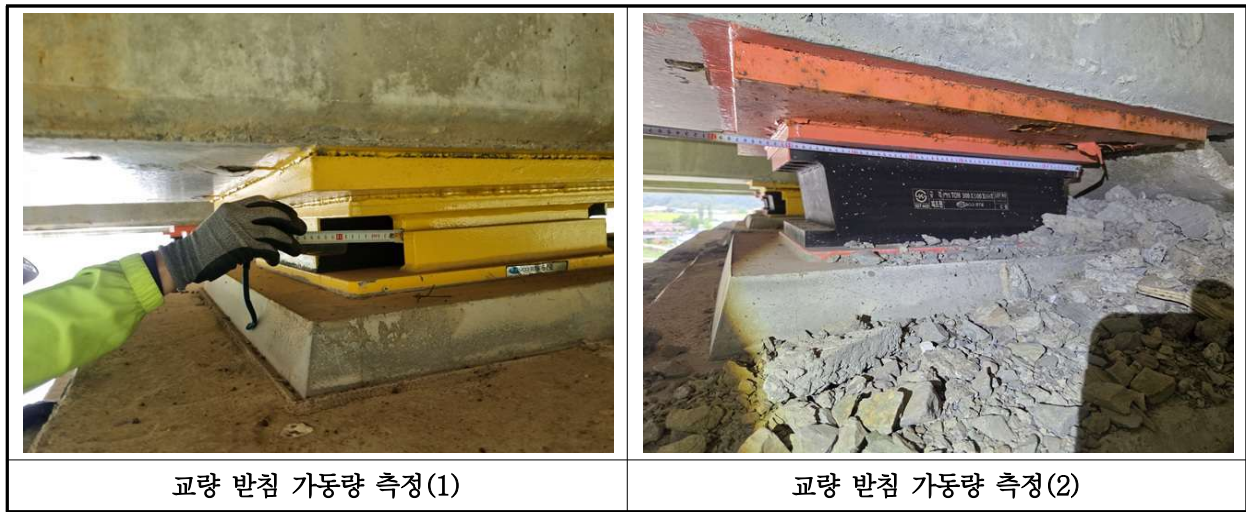
【사진 20.3.16】 교량받침 이동량 측정
