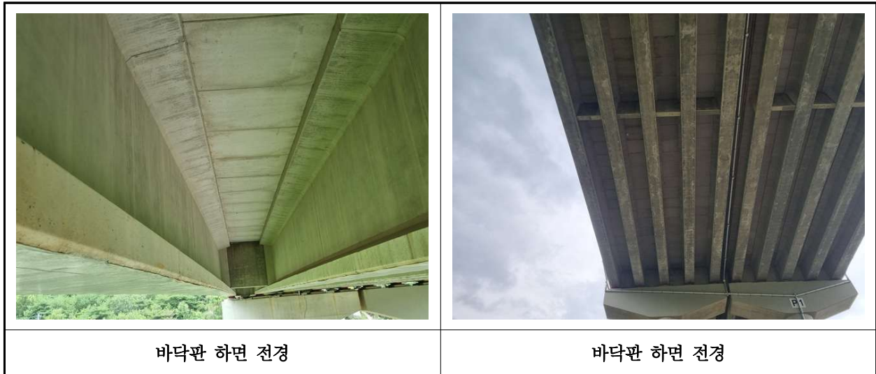
【사진 20.3.29】 바닥판하면 전경
