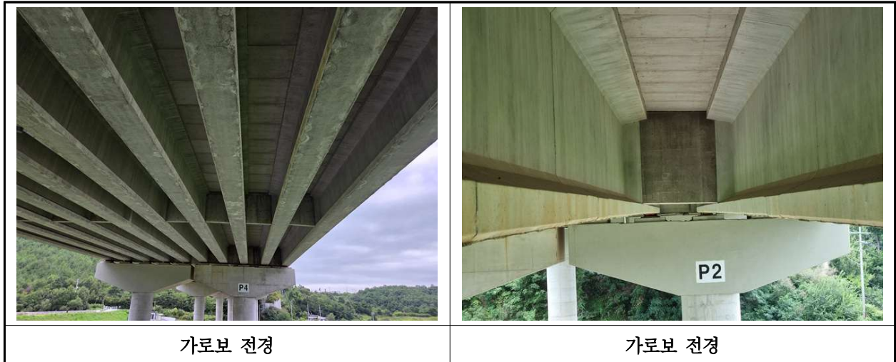
【사진 20.3.6】 가로보 전경
