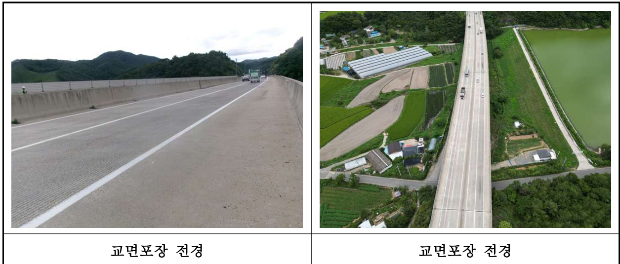
【사진 20.3.47】 교면포장 전경
