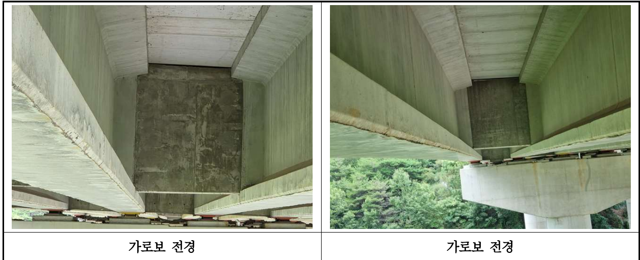
【사진 20.3.33】 가로보 전경
