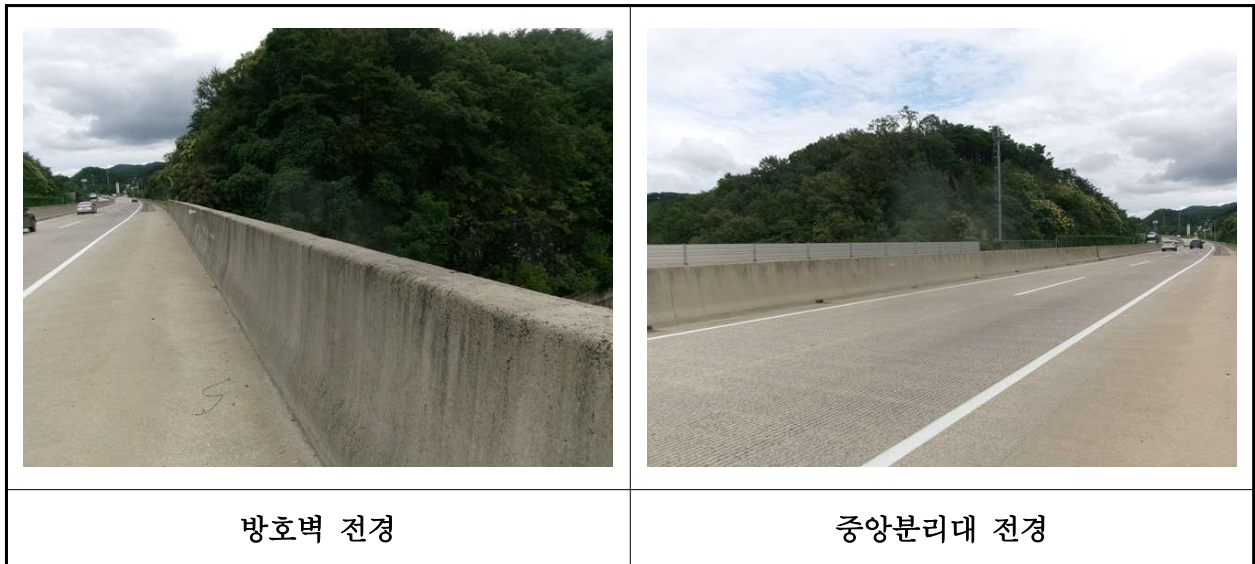
【사진 20.3.51】 방호벽 및 중앙분리대 전경
